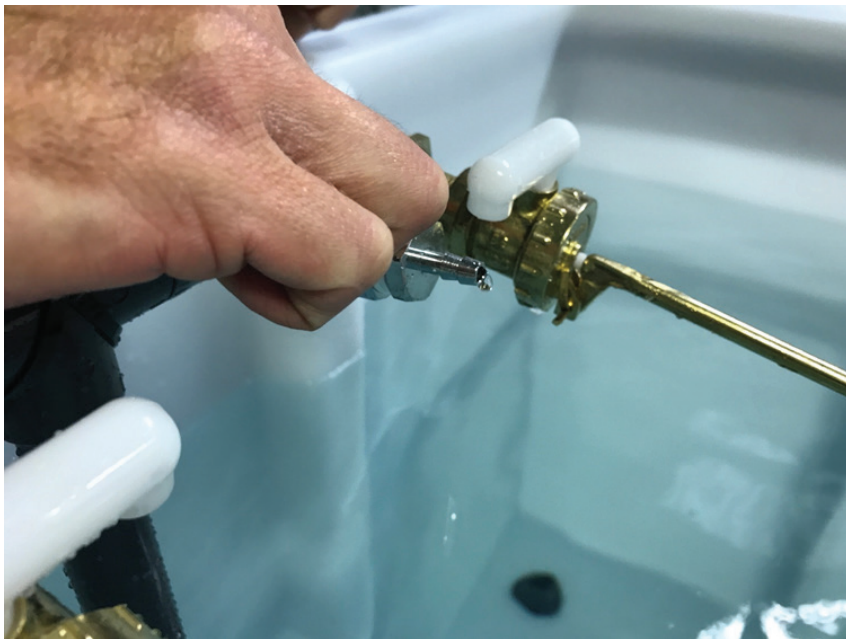
Fabrieksinstelling: water druppelt constant uit de handbediende stortklep voor waterverversing
